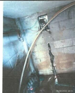
Foto 2: cambio de caja de flipones, cambio de cableado y tomacorrientes
