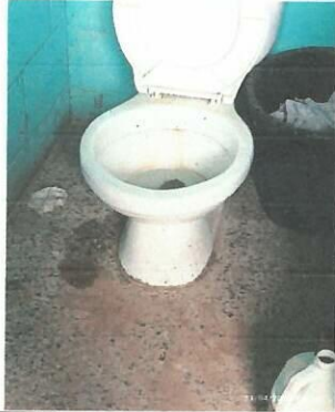
Foto1: reparación de baños y azulejos
